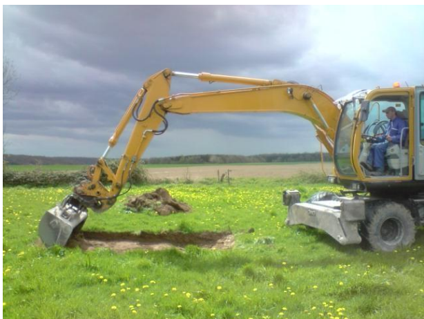
Photographie 1 : Décapage à la pelle
