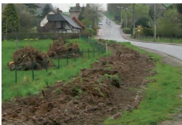
↑ Préparation de l'emprise du talus.
