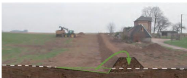
1 Exemple de décapage en pied de talus.
