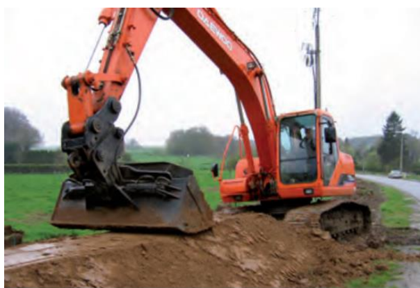
↑ Nivellement des flancs et du sommet.
