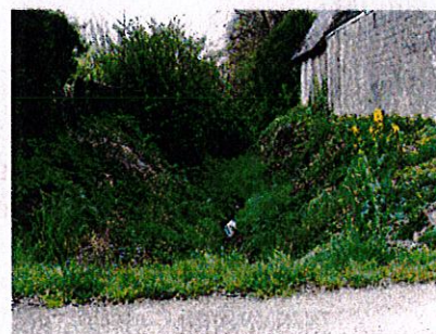
Des fossés canalisent et limitent le risque dans le bourg
