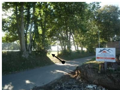
Accès à la zone AU au niveau de la passée existante qui, une fois redimensionnée, pourra servir de refuge
