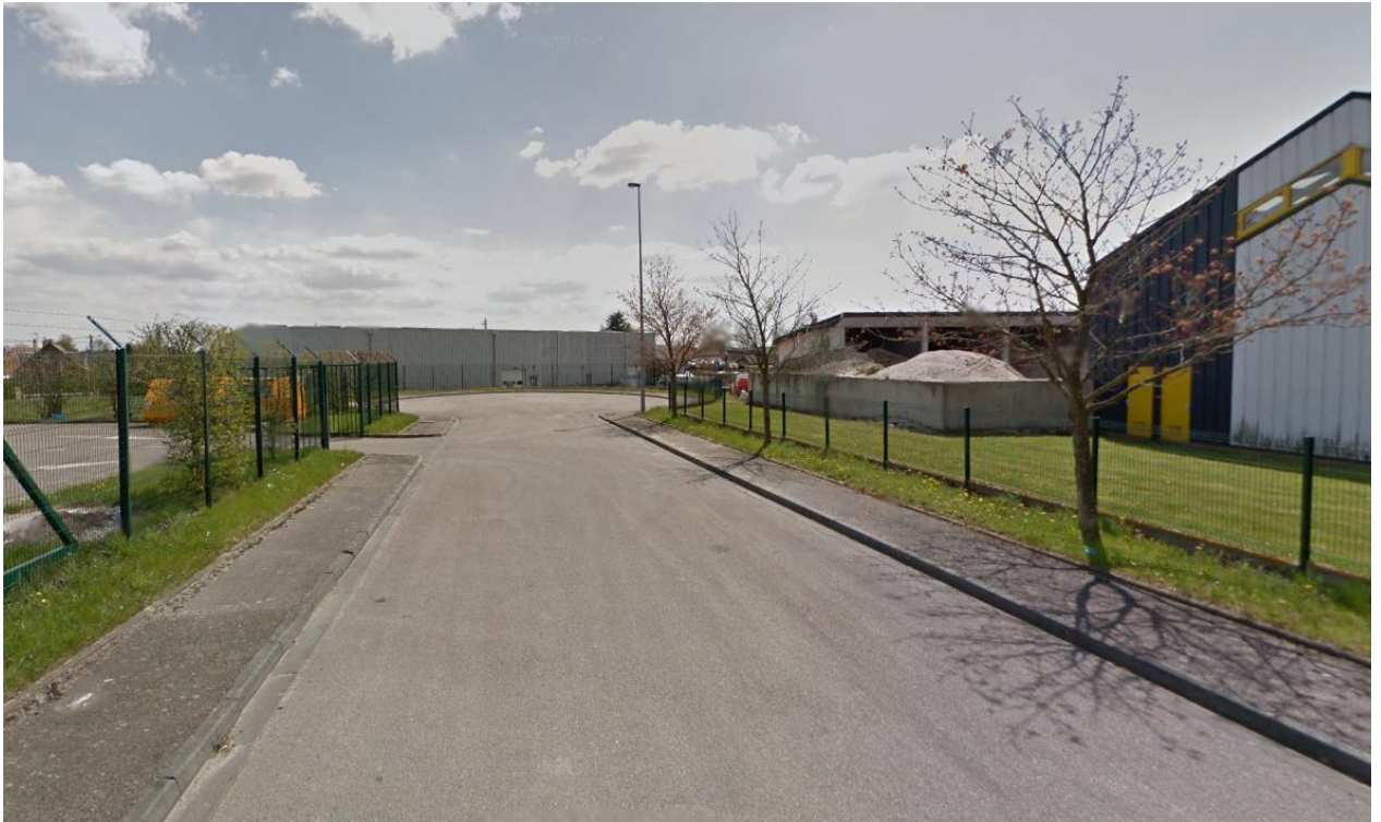
Intérieur de la zone d'Orival (source Google Street View)
