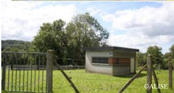
Photo : Captage des Annettes (Source : ALISE Environnement)
