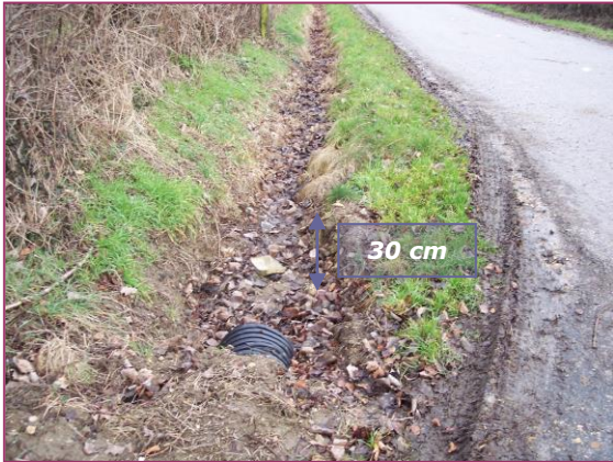
8. et 8'. Les fossés aménagés de part et d'autre de la chaussée témoignent de ruissellements hétérogènes
