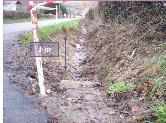
8. et 8'. Les fossés aménagés de part et d'autre de la chaussée témoignent de ruissellements hétérogènes
