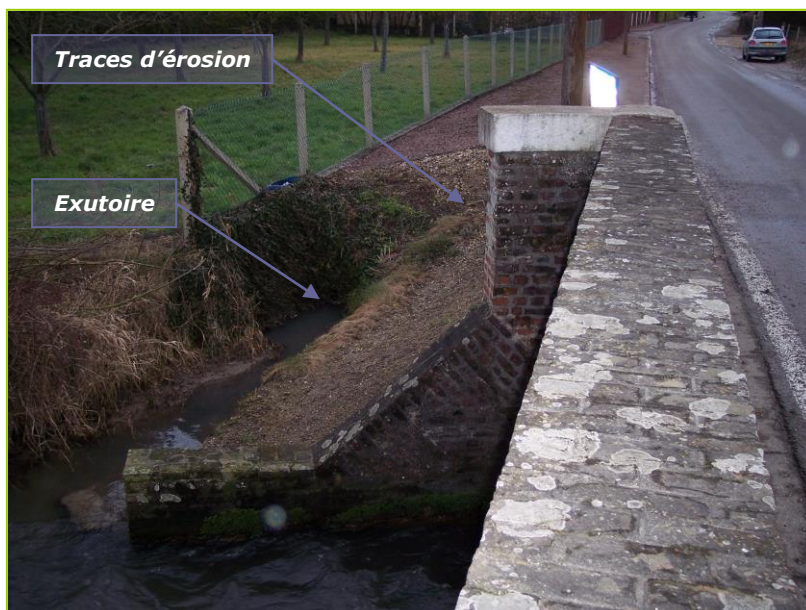
6. Vue depuis le pont. Exutoire du réseau de gestion des eaux de ruissellement
