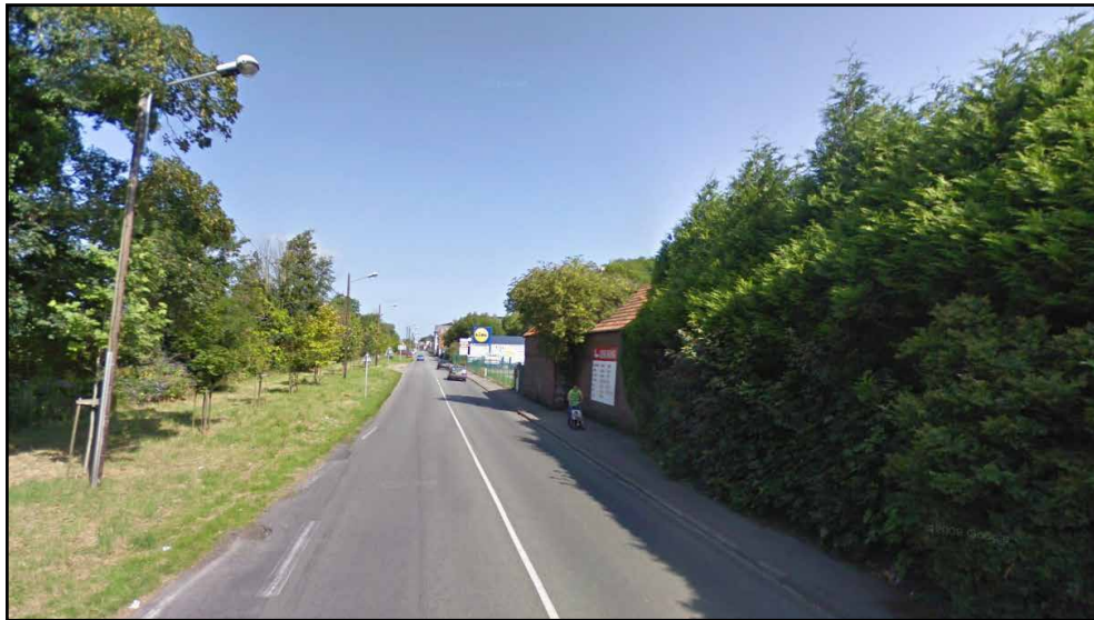
Vue depuis la route de Bonne Nouvelle, en direction du Pollet
