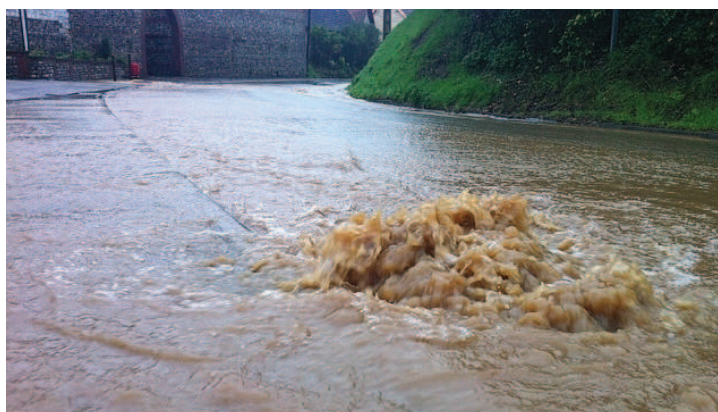
Photographie 7 : Ruissellements et saturation des réseaux EP à Puys (source : France 3)
