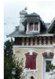
Mur de raval
