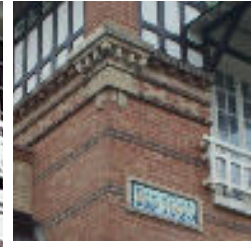
Assise en encorbellement des poteaux d'angle
