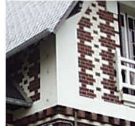
Motif brique sur le mur de raval. Modénature d'angle en enduit lisse.
