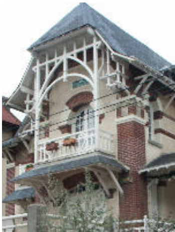
La Coquette – Charpente cintrée sur loggia
