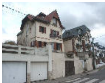
La Gapaudière – enduite, manque d'éléments décoratifs
