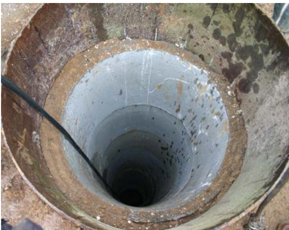
Photographie n° 12: Réalisation d'un puits et expertise d'une marnière
