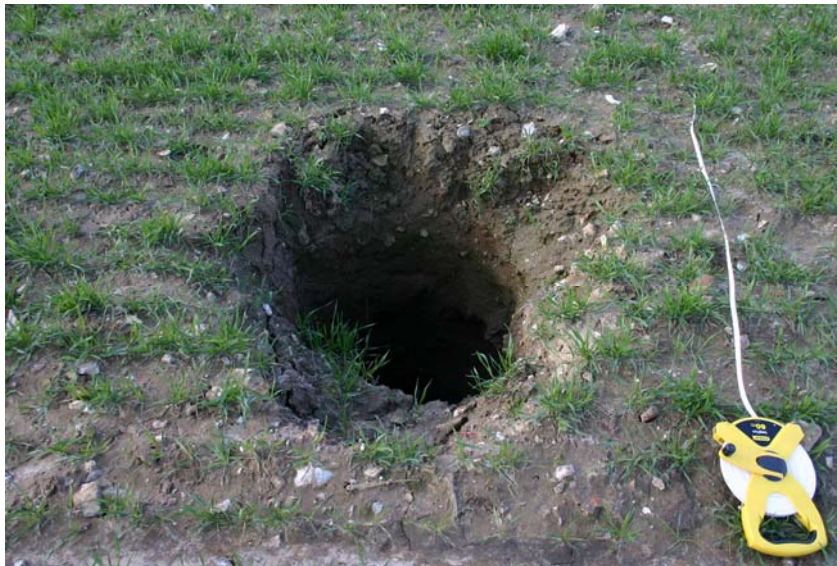
Photographie n° 3: Effondrement d'une cheminée
