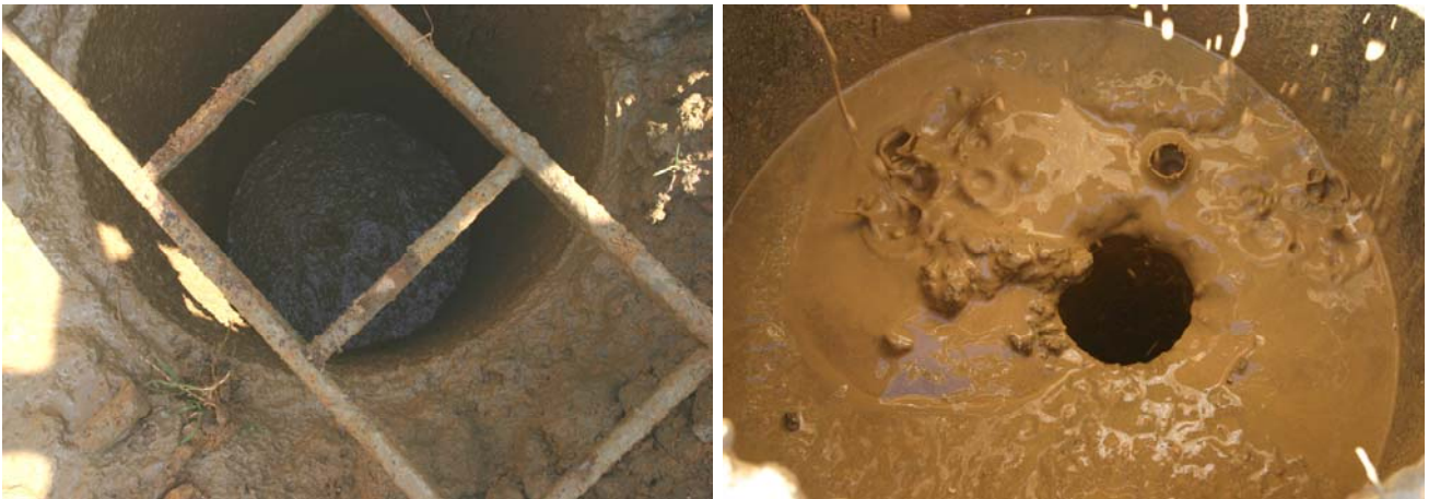
Photographie n° 13: Remblaiement d'une marnière
