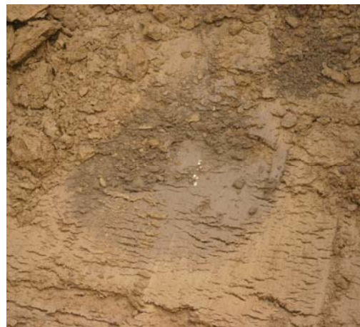
Photographie n° 10: Découverte d'un puits de marnière lors d'un décapage
