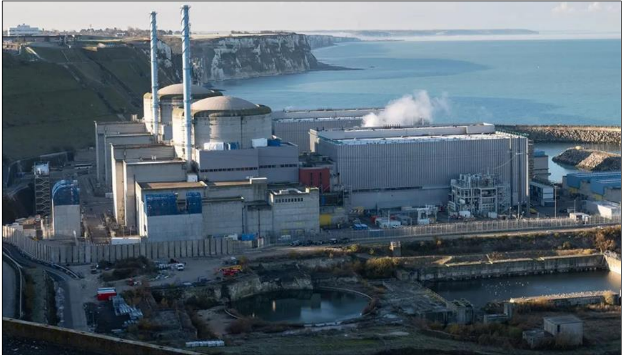
(Photographie du chantier d'un des réacteurs EPR à Penly)
