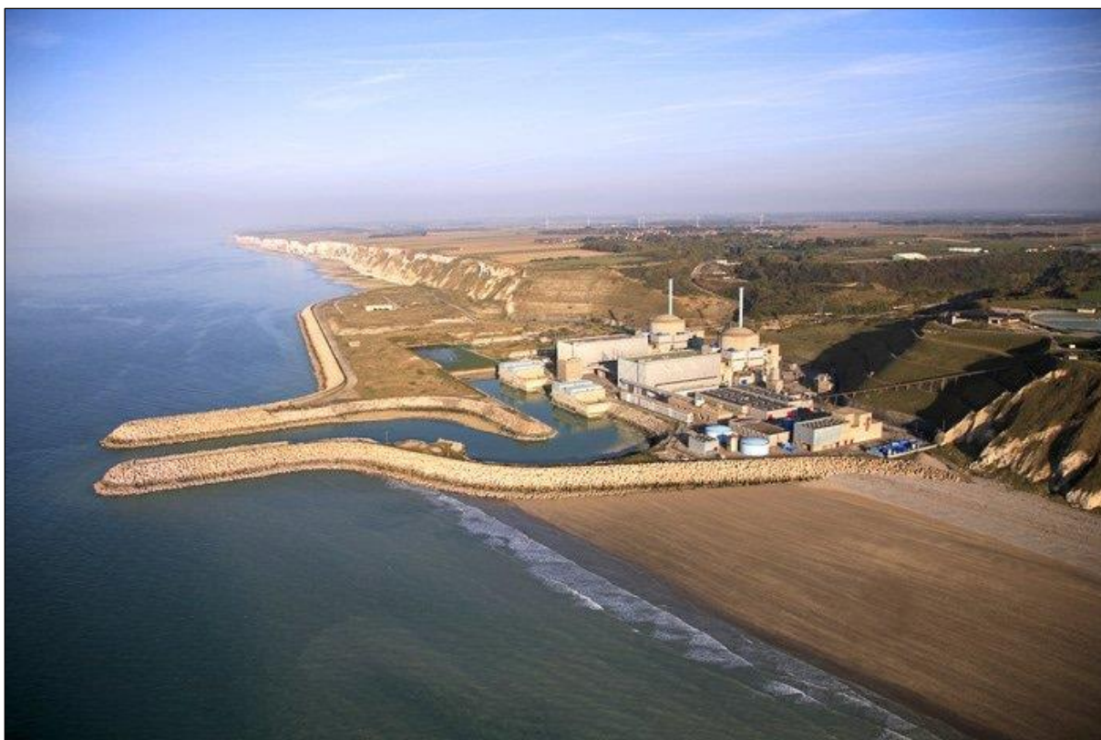
(Photographie aérienne de la centrale de Penly)
