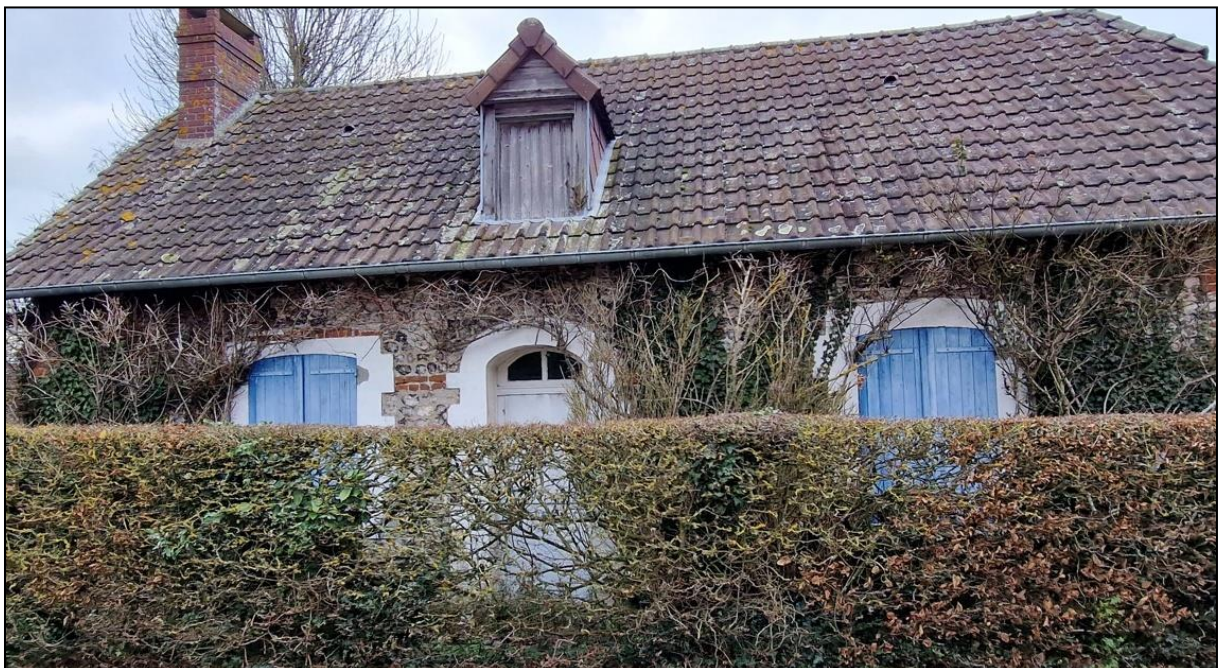
Maison individuelle construite en pierre à Belleville-Sur-Mer
