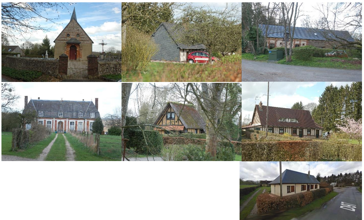
Illustration 58 : Constructions de qualité autour de l'église et du château
