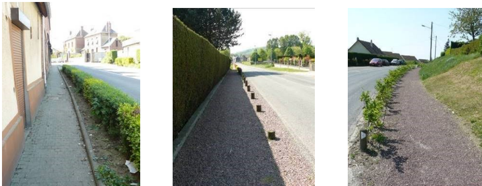
Aménagements permettant des circulations piétonnes sécurisées en bordure des voiries principales
