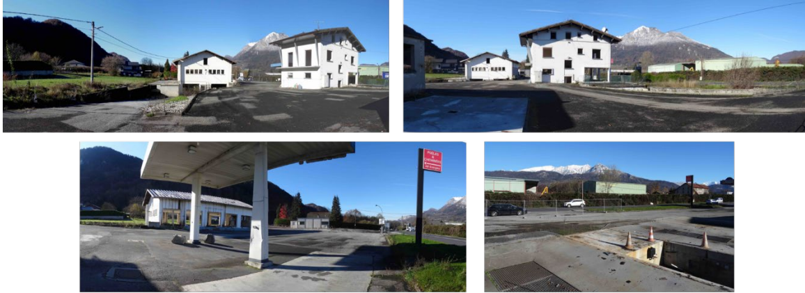
Une vaste plateforme en enrobé support de bâtiments désaffectée
