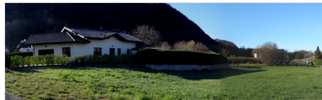
Façade Sud, en co-visibilité avec le pavillonnaire riverain
