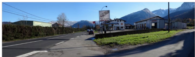
Route Blanche (RD) en façade Nord du site
