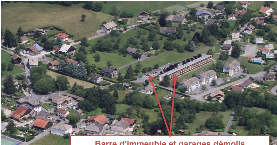
Barre d'immeuble et garages démolis
