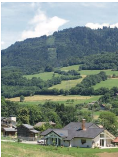
Ligne électrique au-dessus de la forêt des Brasses
