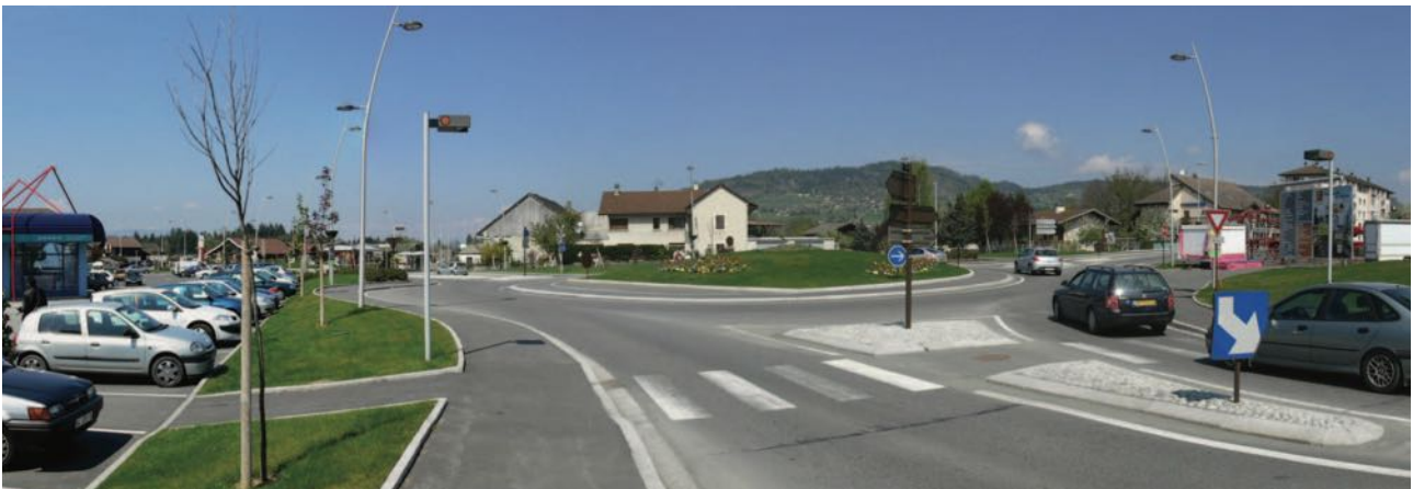
Vue sur l'un des carrefours giratoires qui marque la traversée du quartier des Brochets au droit de la RD 907 en direction de Fillinges : Un espace à caractère routier, bordé par une alternance d'habitats individuels et collectifs et de bâtiments liés aux activités commerciales et artisanales.
