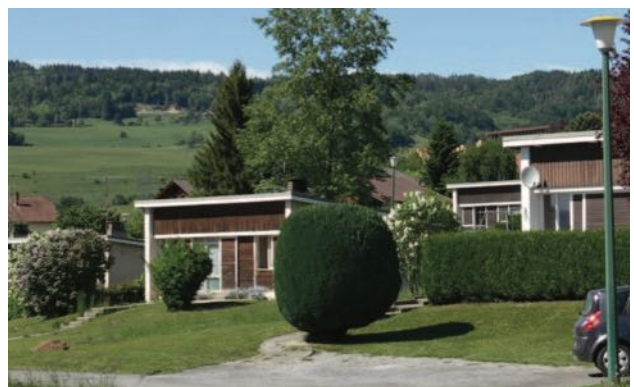
Les logements construits lors de l'arrivée de l'usine Gambin en 1960 dont certains perdurent aujourd'hui
