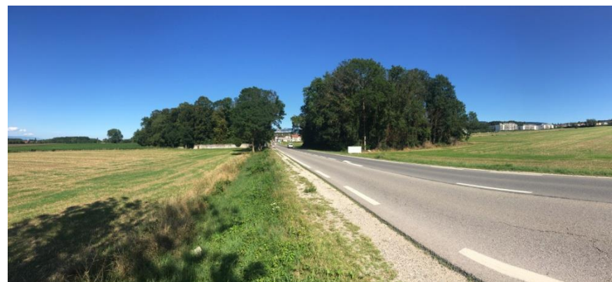
RD 1206 : Boisement existants à proximité du point de raccordement
