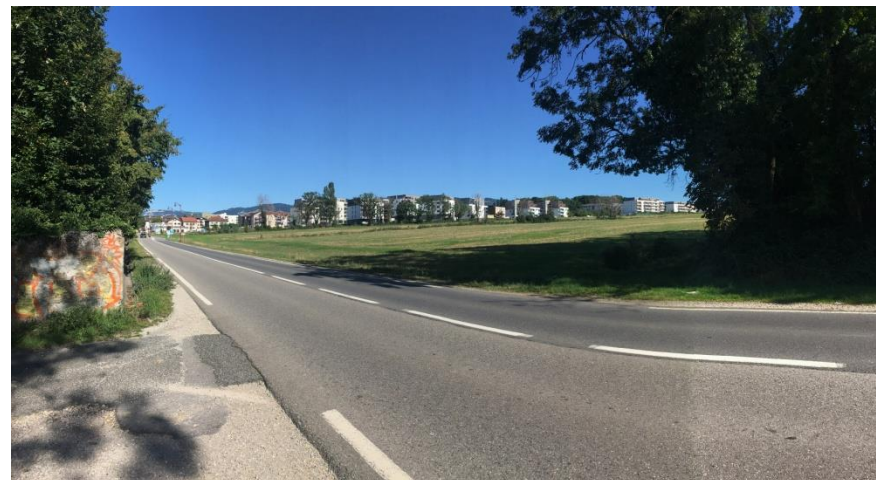
RD 1206 : au droit du raccordement avec le futur diffuseur
