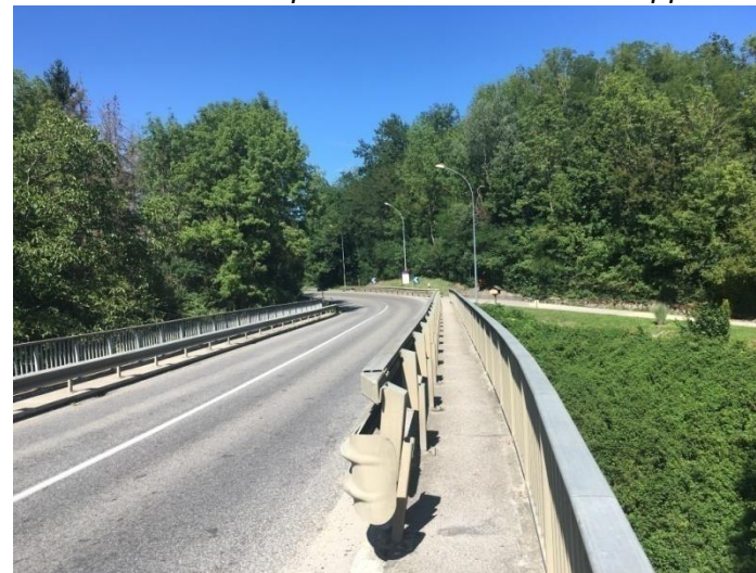
RD 1206 : Pont sur La Laire - passage piétons
