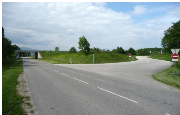
Route de la Maison Blanche (les Granges) Passage sous l'autoroute A 40
