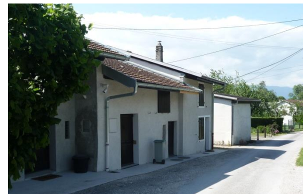
Humilly – Chemin de la Traversière
