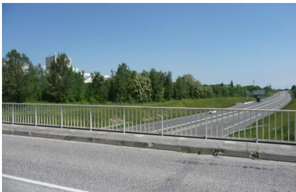
RD 1206 / route de la Gare au droit de l'autoroute A 40
