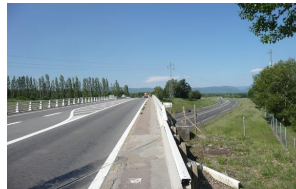
RD 1206 au droit de l'autoroute A 40
