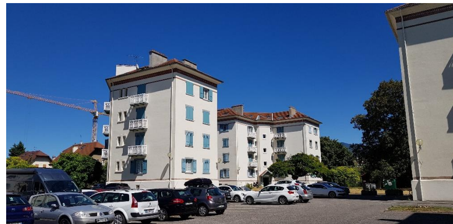
Figure 21 - La cité SCNF voisine, construite autour d'un espace collectif central, vert et planté
