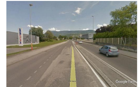
La RD150, ses larges délaissés dans la zone industrielle
