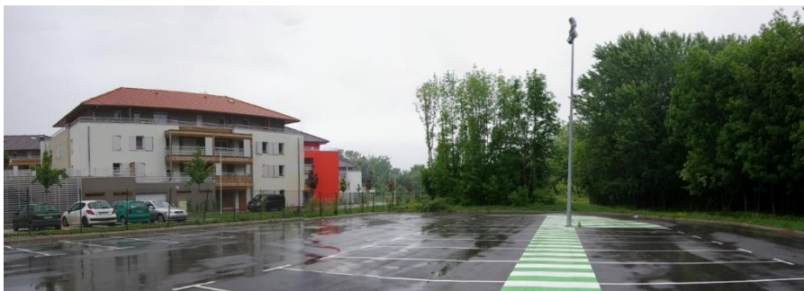
La partie en mutation, insertion séparée de piste cyclable et piétonne, résidence collective sécurisée, centre commercial et son parking jouxtant le Foron et sa ripisylve
