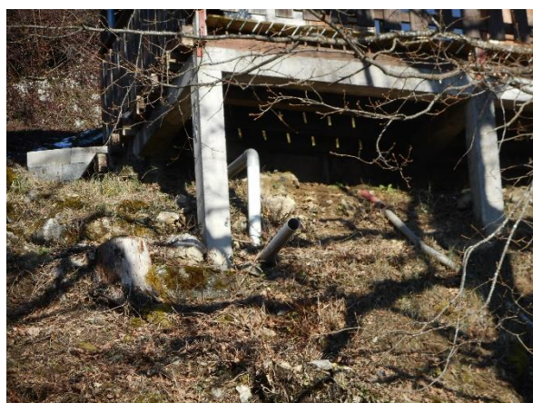
Photographie 5. Vue d'un rejet de gouttière (Verchaix Haut)
