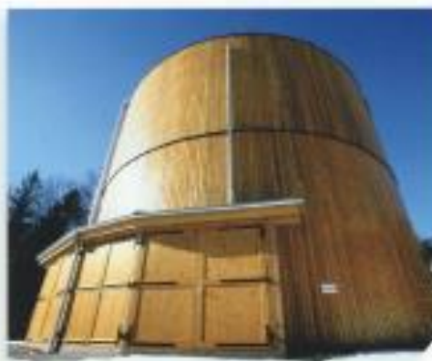
Les boues introduites dans ce digesteur se dégradent et produisent du biogaz (méthane) qui va alimenter chaudières et cogénérateur.
