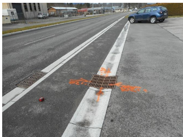
Photographie 11. Vue d'une grille avaloir en bordure de RD (Verchaix Bas)
