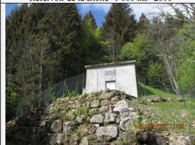
Réservoir des Chaumettes- 200 m3- 2006
