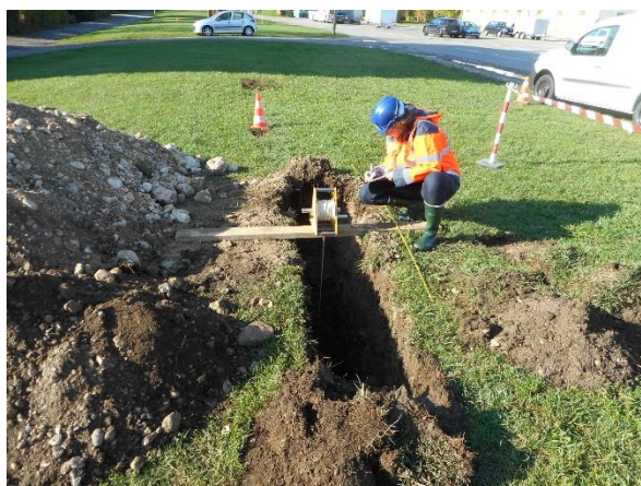
Figure 21. Exemple de tranchée réalisée pour un essai d'infiltration
