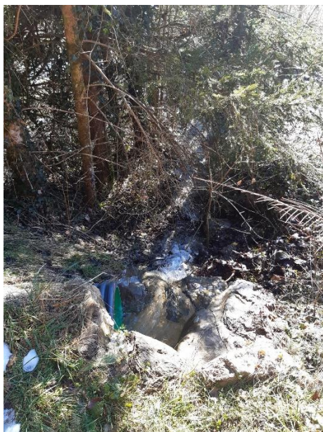
Photographie 3. Exutoire du réseau superficiel route de Chaumieu (Verchaix Haut)
