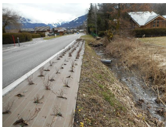
Photographie 14. Exutoire du réseau superficiel en bordure de RD907 (Verchaix Bas)
