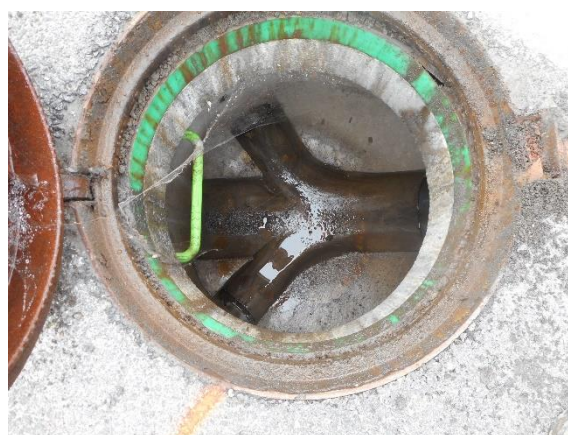
Photographie 12. Vue de l'intérieur d'un regard sur réseau EP de la RD (Verchaix Bas)
