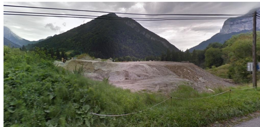
En partie Nord du site : depuis la route de Champriand, le site de décharge des déchets inertes
