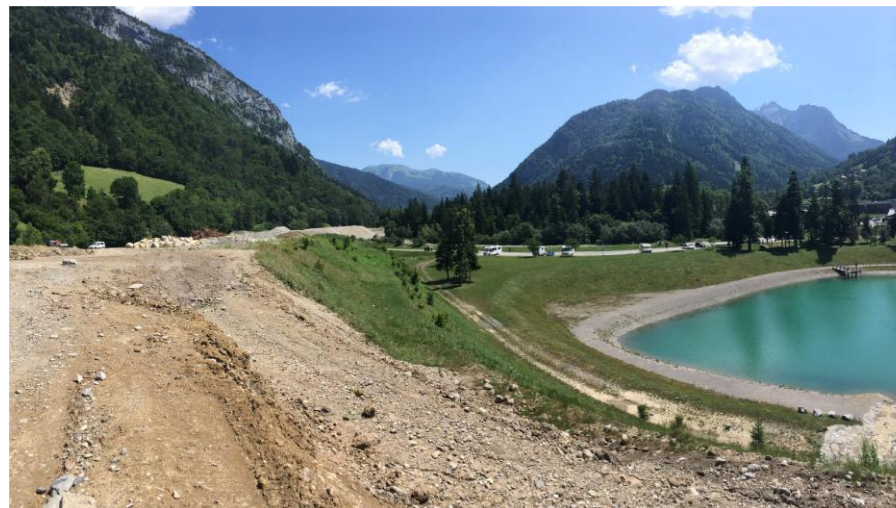
En partie Ouest du site : les remblais surplombant le lac
