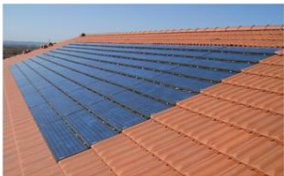
Tuiles et panneaux intégrés en toiture
