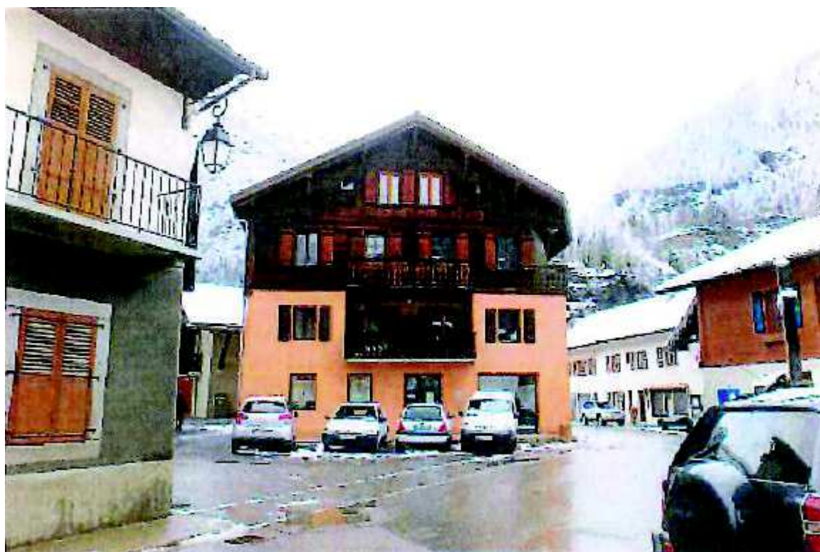
Le stationnement en bande ouvert sur l'espace public
