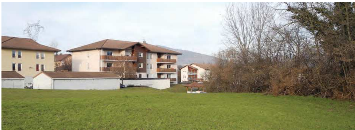
Logements collectifs à l'entrée de la zone
