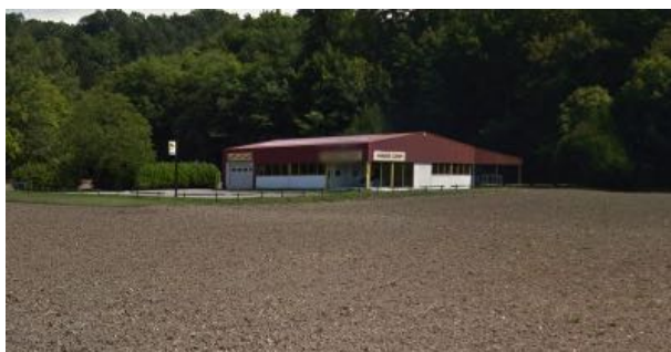
Vue sur le garage automobile
