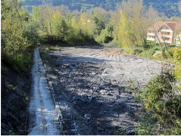
Le torrent de Reninge canalisé en amont de la confluence avec l'Arve
