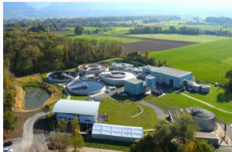
Unité de dépollution ARVEA (source CCPR)
