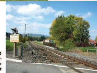
Intersection sur la route du village entre le centre-bourg et les Champs de Chant
