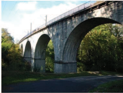
Ouvrage d'art en aqueduc au niveau du Chêne
