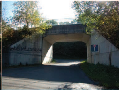
Ouvrage d'art au niveau de la Montagnère
