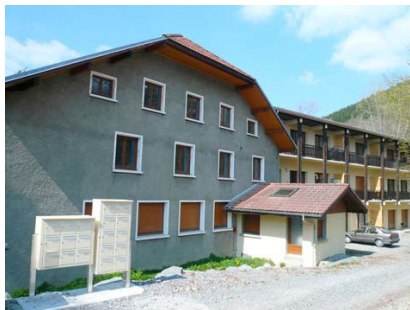
Centre de vacances, transformé en logements collectifs
