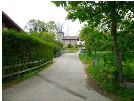
La Beunaz – Aménagement de la traversée du hameau. Ouvrage de soutènement de la RD52
