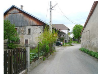
Hameau chez Thiollay – Implantations bâties en limite de l'espace public ou en retrait. Clôture ou cour de transition entre la maison et la rue.
