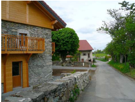
Murs de clôture dans les cœurs de hameau
