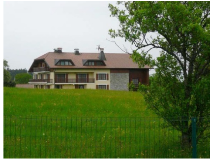
Rénovation / extension chez Gremey
