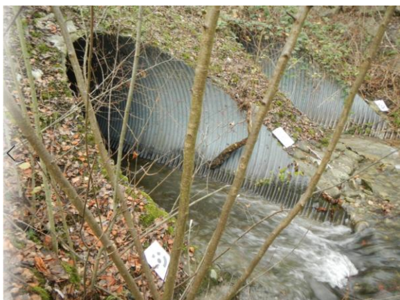
Figure 8 : Ouvrage de traversée de l'A41
