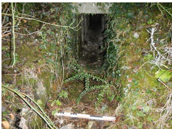
Figure 10 : Ouvrage de traversée de la voie SNCF
