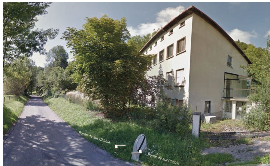
La colonie aux abords du site, vue depuis la Route Sur Châble le Nord Est (cône 2)
