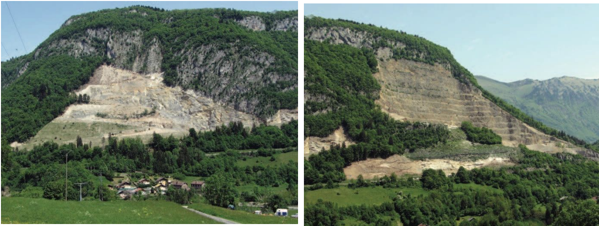
Fronts de taille des carrières de roches massives
