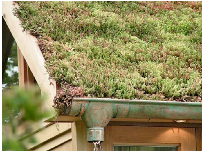
Exemple toiture végétalisée
