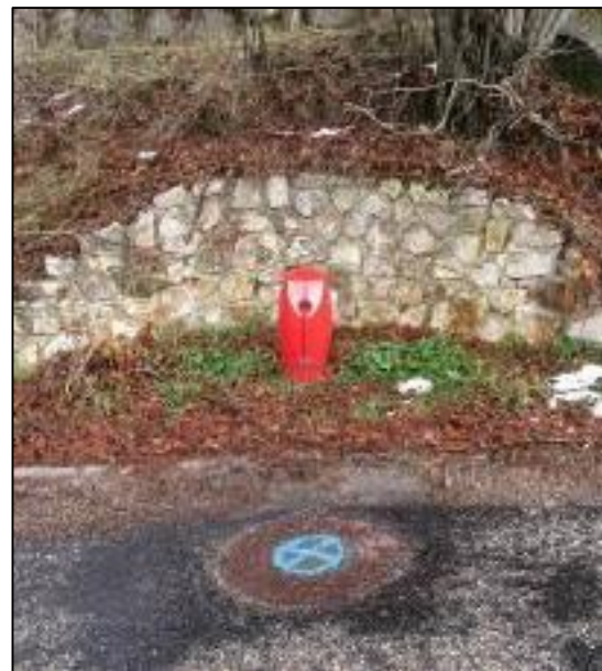
Poteau d'Incendie SB-1 situé à Saint-Blaise
