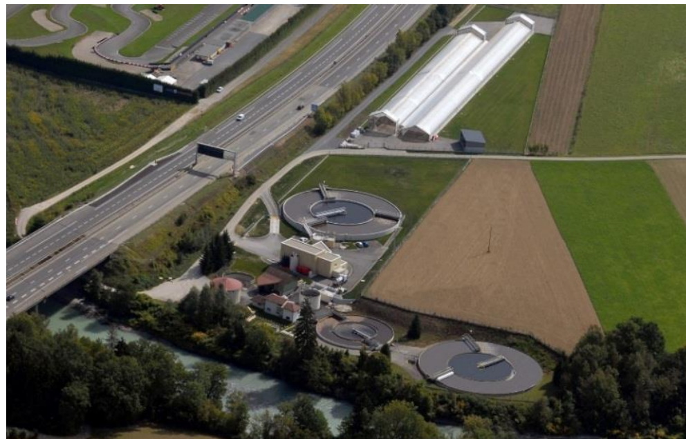
Station d'épuration intercommunale de Bellecombe (Scientrier)
