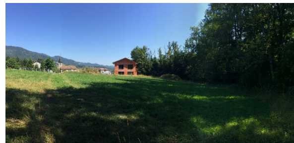
Construction en cours sur la zone U. Source : Agrestis
