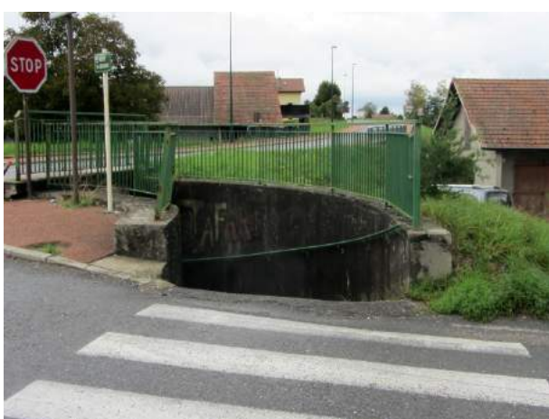
Passage piéton sous la RD2
