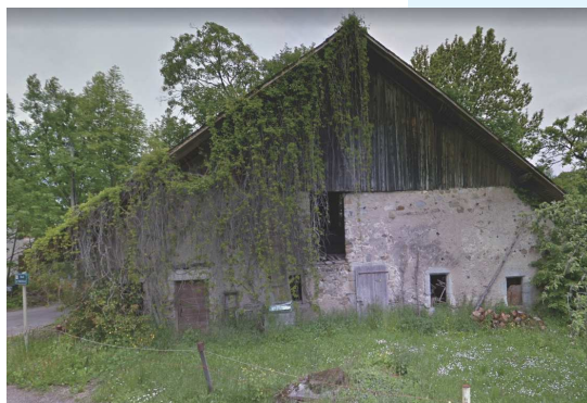
Bâtiment pouvant faire l'objet d'un changement de destination aux Carmes
