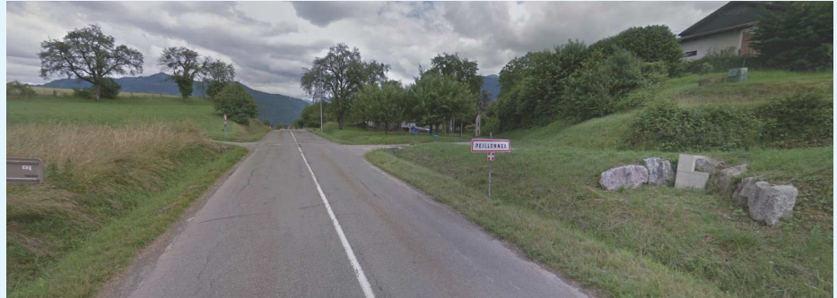
L'entrée nord-ouest par la route de Bonneville
