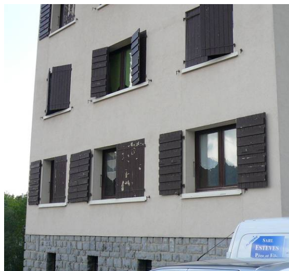
Isolation par l'extérieur, bavettes métalliques à la place des appuis. Plateau d'Assy
