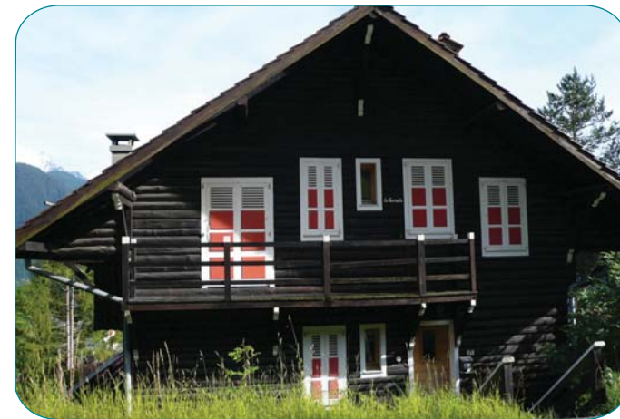
Chalet plateau d'Assy, la « Coccinelle ». Ici le bois prédomine avec une structure pièce sur pièce.
