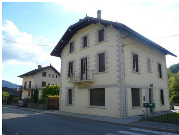
Maison en bordure de rue, caractéristique du type. Mais le rez de chaussé a subi des transformations. Chedde
