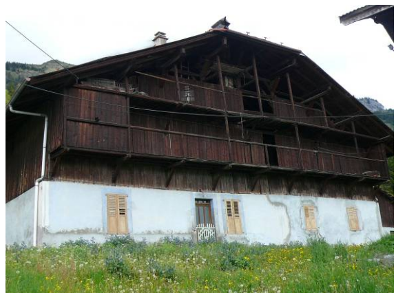
Maison passerande Cran. Rez de chaussée maçonné (les ouvertures ont été agrandies vers 1930), étage et comble en bois, toit à deux pans avec fausse croupe dite « Allemande ».
