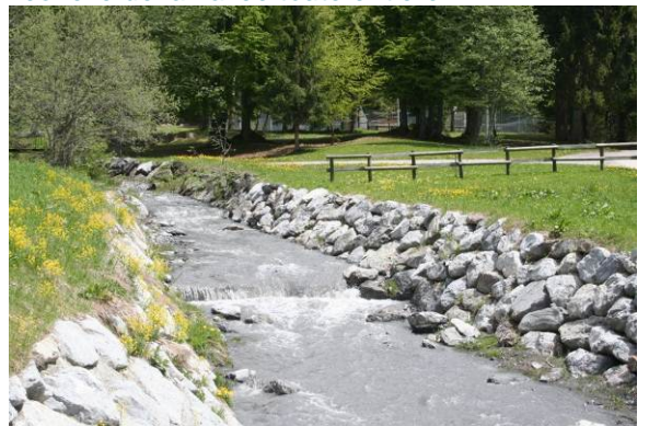
Canalisation des cours d'eau par des enrochements qui artificialisent les cours d'eau et nuisent à l'image de naturalité qu'ils évoquent (dégradation des ambiances paysagères, perte de biodiversité)
