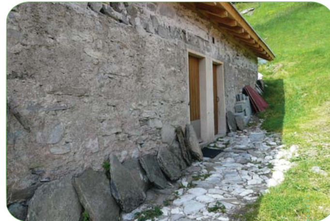
Alpage de Curalla. Toiture refaite, chevrons apparents
