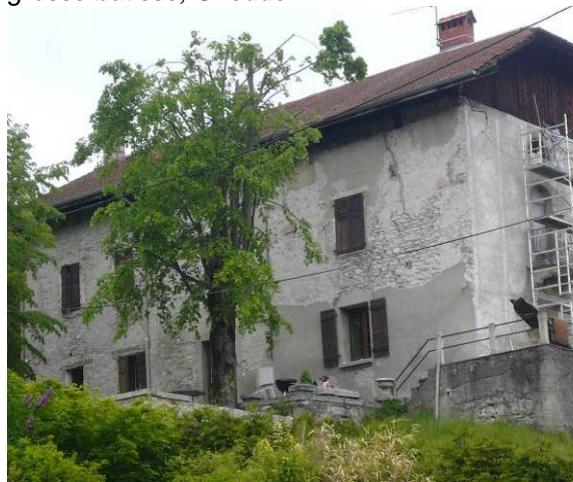
Maison forte de Lucinges à l'entrée de Passy. Travaux en cours
