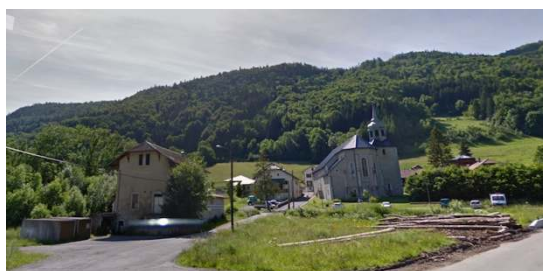
La structure béton des petits garages communaux pourra être intégrée au bâtiment technique et d'accueil.
