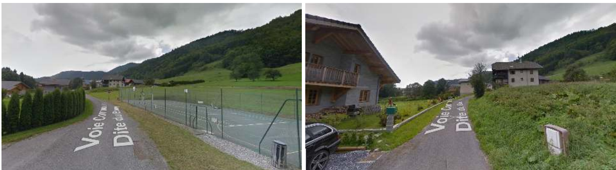
Secteur du tennis : le secteur équipements sportifs laissera une frange verte, le terrain communal s'urbanisera en continuité des collectifs existants.
