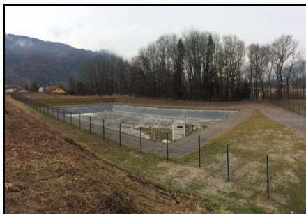
Bassin de rétention ZAC ECOTEC
