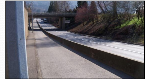
Passage sous la RD 1205
