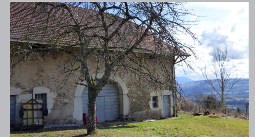
Vue sur la bâtisse devant faire l'objet d'un projet de réhabilitation
