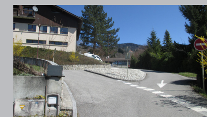
Vue sur le carrefour entre le chemin des Terreaux et le chemin des Jardins
