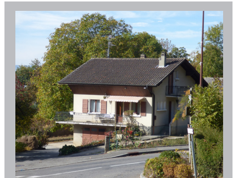
Vue sur l'habitation existante
