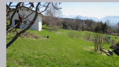
Vue sur le local technique situé en entrée Ouest du site
