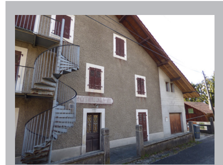
Vue sur le bâti existant (ancien hôtel Janin)
