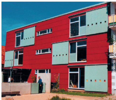
Exemple de protection solaire mobile sur façade ouest
