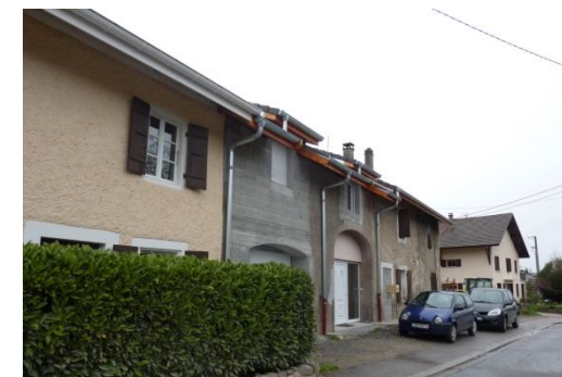
Bâti ancien à l'alignement en cours de restauration
