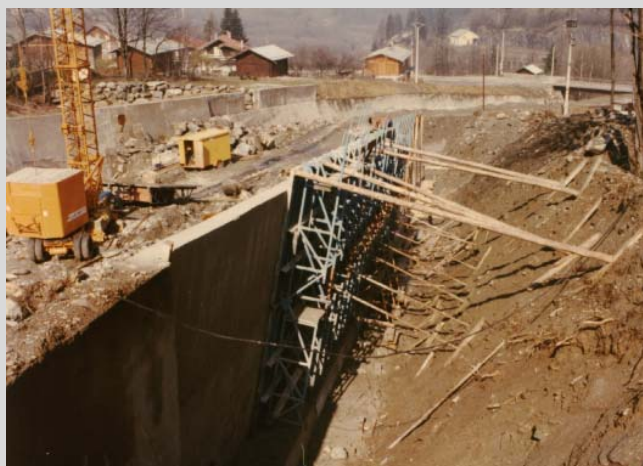
Endiguement du bief inférieur – avril 1977
