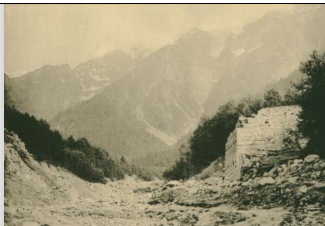
Pont de la route des Houches emporté par la crue du 13 juillet 1895
