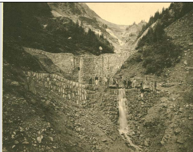
Barrages du ravin des Arandellys
