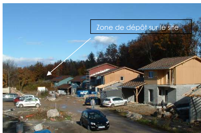
Proximité avec le hameau du Clos des Chênes ici en chantier en 2008
