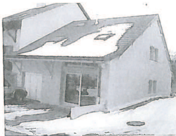
Toiture à 2 pans avec « queue de vache » posée sur chevrons débordants.
