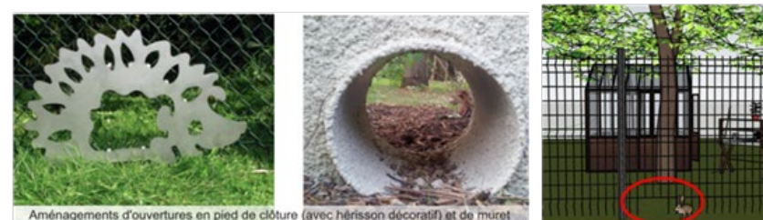
Figure 3 : Exemples d'aménagement de passages en faveur de la faune dans les clôtures/murs
