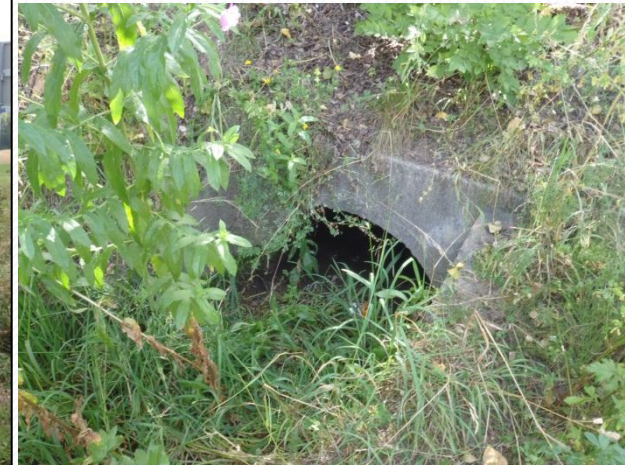
Buse EP Ø 800 en grande partie obstruée (de l'autre côté du tunnel sous l'autoroute)
