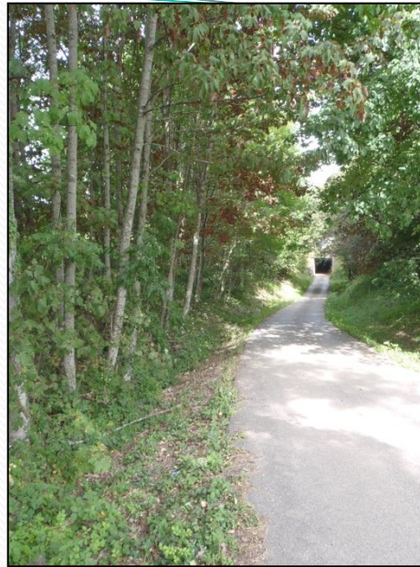
Fossé au sud de la zone. Le fossé se « perd » peu avant l'entrée du tunnel.
