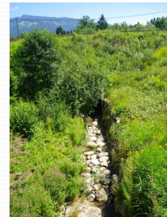
Enrochement de berges sur le Ruisseau de la Merle – Au Chêne
