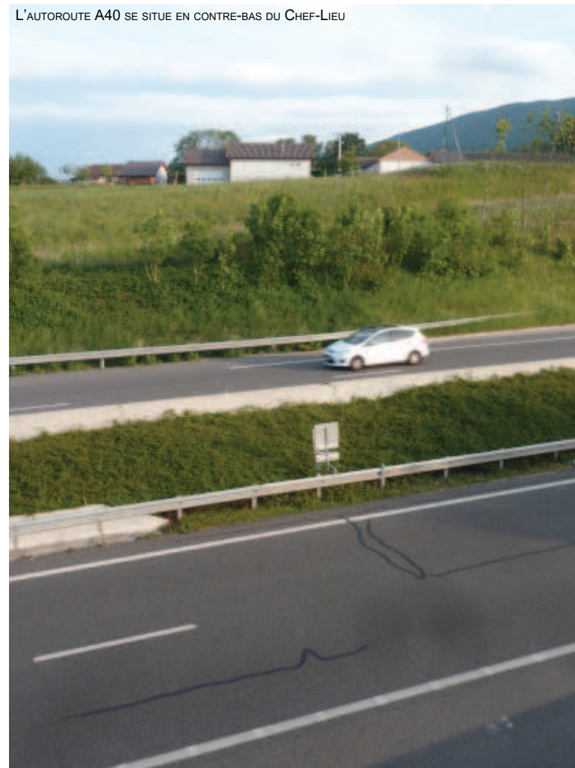
L'AUTOROUTE A40 SE SITUE EN CONTRE-BAS DU CHEF-LIEU
